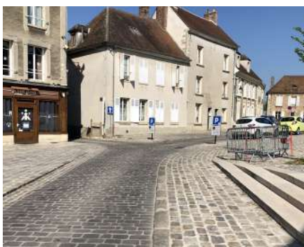
L'utilisation de pavés de grès de réemploi sciés limite les bruits de roulement sur la chaussée (Marines).
