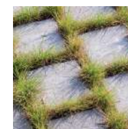
Pavés joints engazonnés
