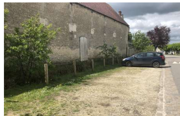
Noue plantée en fond de parking pour recueillir les eaux de ruissellement (Omerville).
