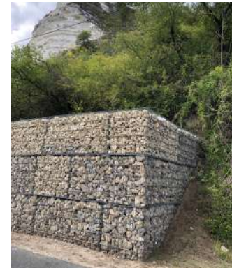
Des gabions pour soutenir la pente (La Roche-Guyon).
