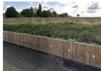
Soutènement de talus en traverses de chêne à section carrée (Moussy).
