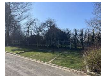
Emplacements en dalles alvéolées engazonnées (Maudétour-en-Vexin).
