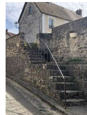
Un garde corps sur-mesure remarquable (Montalet-le-Bois).
