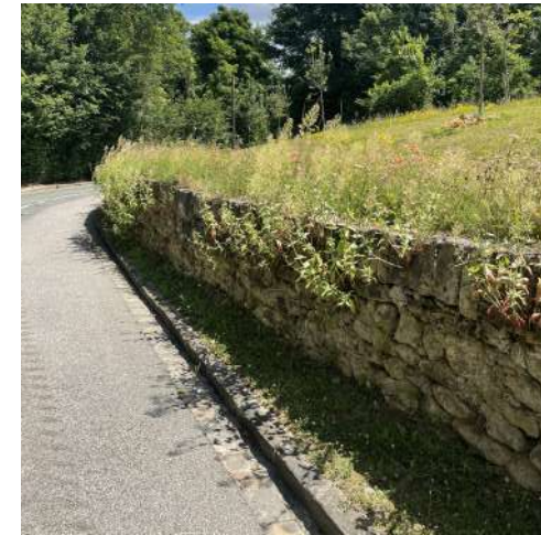
Un mur en pierres sèches (sans mortier) est durable, permet le drainage de l'eau, et accueille la biodiversité : la petite faune y trouve refuge et les plantes s'y installent (Evecquemont).
