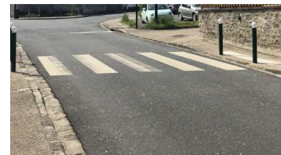
Enrobé « clouté » en coeur de bourg (Arthies).
