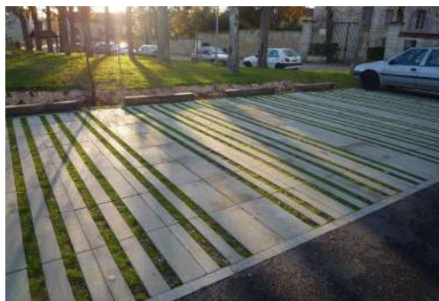
Parking perméable au dessin contemporain et sobre dans un projet à l'identité marquée (Guitrancourt).
