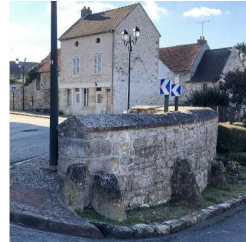
Ouvrage en pierre, témoignage patrimonial (Moussy).
