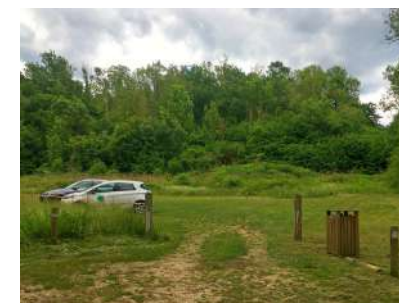
Parking en mélange terre-pierre (Genainville).
