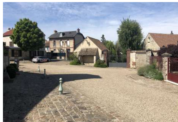
La chaussée en béton désactivé prolonge l'espace dédié aux piétons et s'harmonise avec les pavés de grès (Maudétour-en-Vexin).
