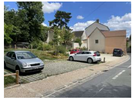
Les travaux réalisés (Evecquemont).
