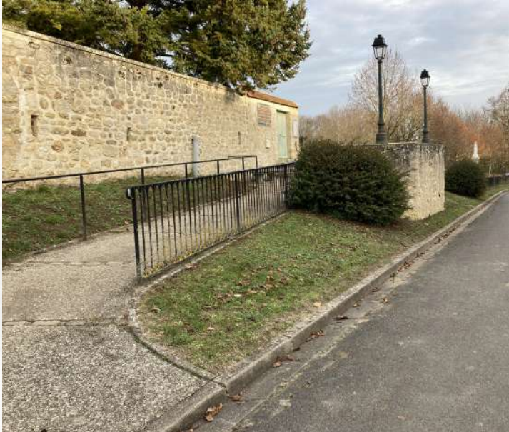
Une rampe accessible à tous traitée avec simplicité en accord avec l'identité vexinoise (Montgeroult).
