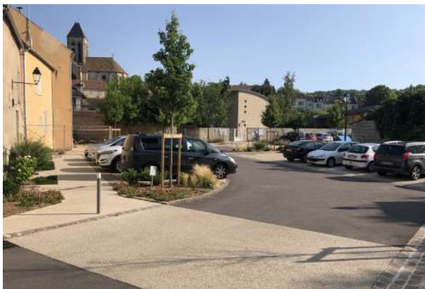
Un parking pour l'école et les commerces du centre (Vétheuil).
