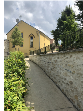
Création d'une rampe et d'un mur de soutènement en pierre (Oinville-sur-Montcient).
