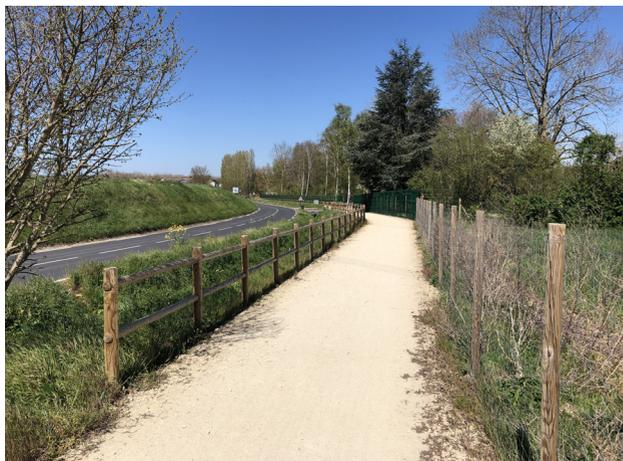
Le sol stabilisé est roulant, la largeur (3 m) permet la double circulation des vélos et des piétons, la sécurité vis-à-vis des automobilistes est assurée (séparation de la route et intersections) par les clôtures en bois, la végétation et la distance par rapport à la chaussée (Liaison entre Sagy et Saillancourt).
