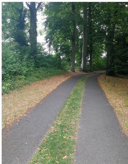
Malgré l'usage d'un revêtement capable de supporter des véhicules lourds, la double bande de roulement séparée par une bande en herbe permet de conserver à cette voie l'aspect d'un modeste chemin rural (Théméricourt).
