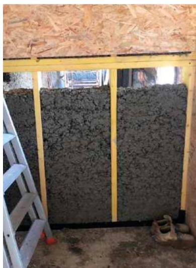
Mur ossature bois et béton de chanvre
