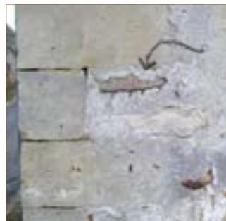
En fonction de l'exposition du mur, de la qualité des pierres, l'enduit pouvait être à pierre vue ou plein. Dans la majeure partie des cas, les moellons étaient revêtus d'un enduit venant recouvrir imparfaitement toutes les pierres sauf les chaînages.
