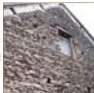
Des pierres plates très dures sont assisées avec un tel soin qu'elles semblent montées sans liant, comparables à une architecture de pierres sèches.
