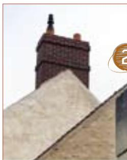
De forme concave, les solins créent une harmonieuse liaison entre les ouvrages de couverture et de maçonnerie.
